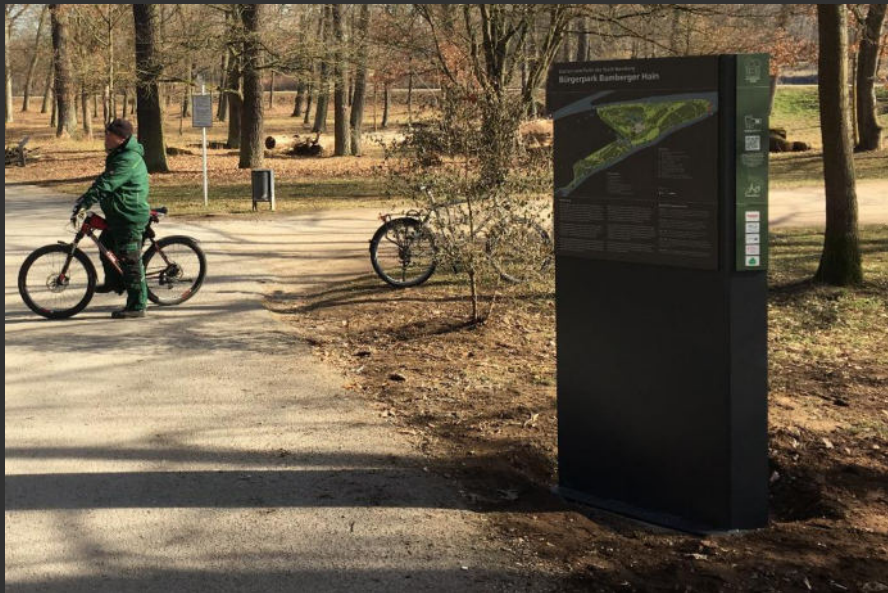
Aufstellung der Eingangsstelen im Februar 2019
