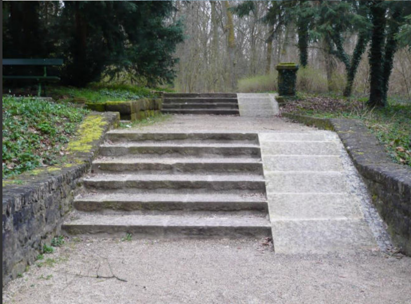
Treppensanierung und Einbau zweier Rampen am Hainweiher, August 2019
