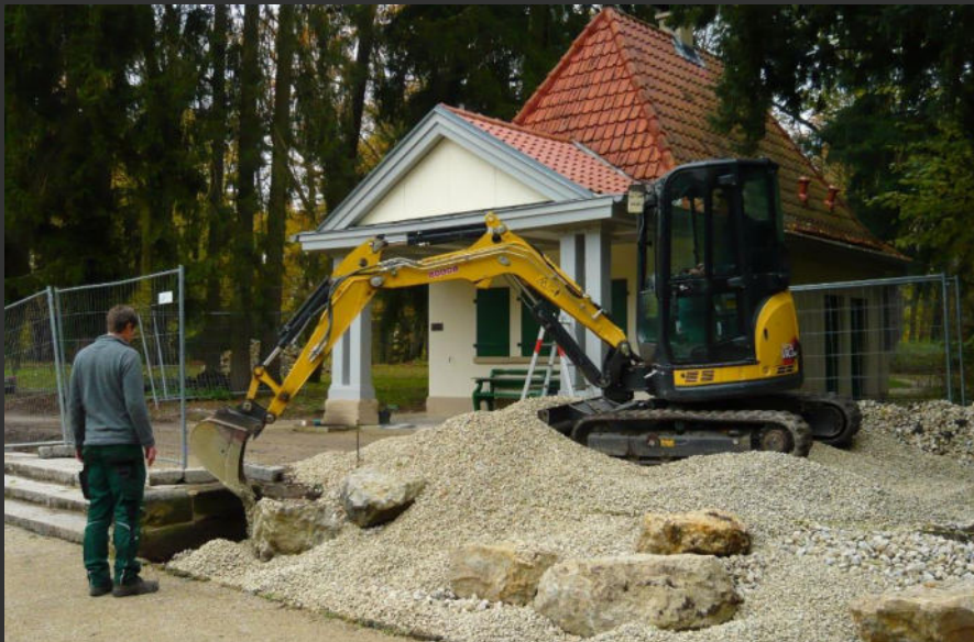
Bau des Jurabeetes, 06.11.2017
