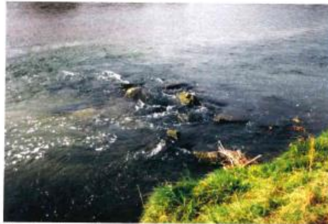
Durchströmte Steinbuhne aus großen Steinblöcken.
