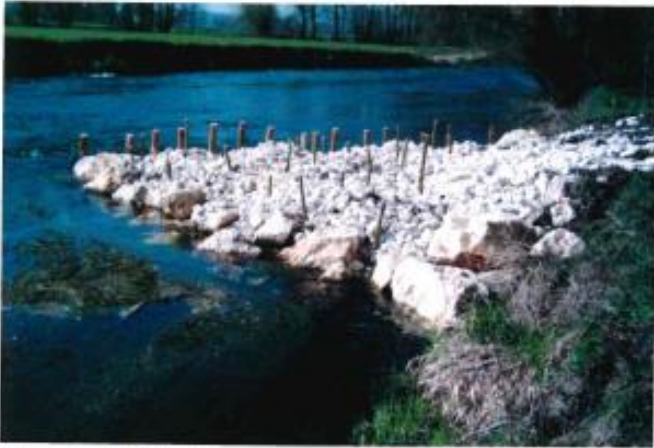
Massive Steinbuhne. Quelle: Thomas Kugel (GWD Rottweil)
