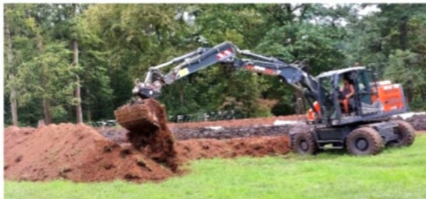
Auf der südlichen Schillerwiese nahe des Berganza-Denkmal wird der Schlamm zum Trocknen abgeladen.
