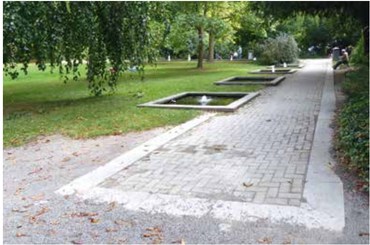
Muschelkalk und Klinkerpflaster: Hier ist der originale Bodenbelag der 1960er Jahre noch vorhanden.
